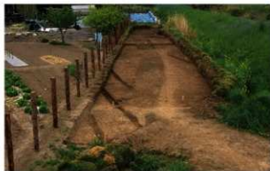
5 C区上層全景（北から）
