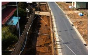
2 B・C区全景 (東から)
