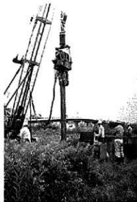
第2図 鉄矢板打設風景
