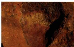
7 第8号製鉄炉右側壁
