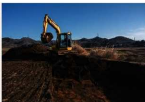
F区 表土除去作業 (北西から)
