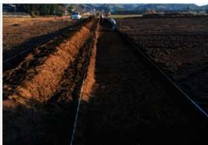
I-2区 トレンチ作業風景(北西から)
