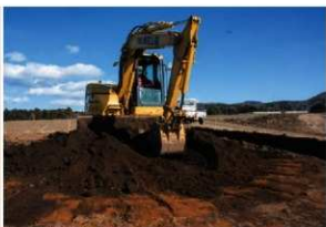
G区 重機表土除去 (西から)
