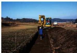
J-3区 トレンチ掘削（南東から）
