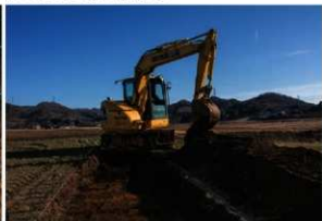
M区 表土除去作業（北西から）
