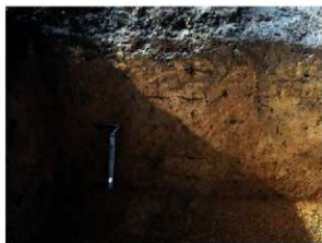
写真4 A区トレンチ6下部
