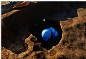
第 92 号土坑作業風景（北西から）
