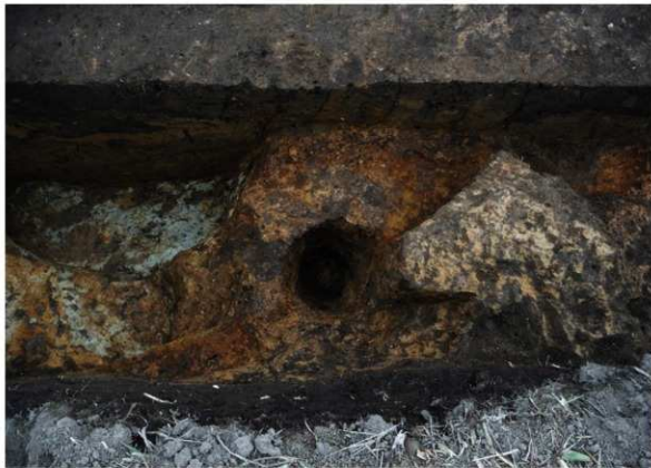
SK-17内 Pit 完靴 (東から)
