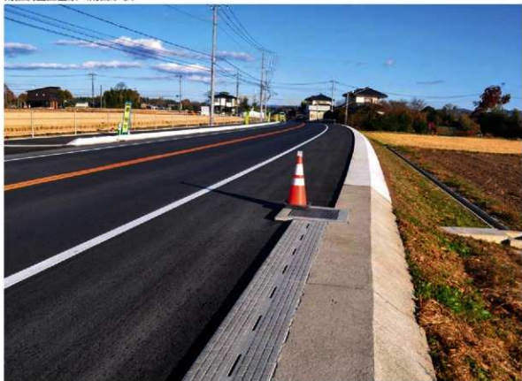
下飯貝遺跡現況（西から）
