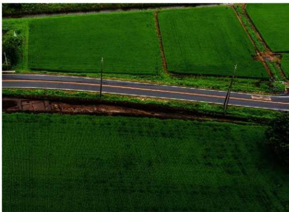
北区調査区西半全景（北から）
