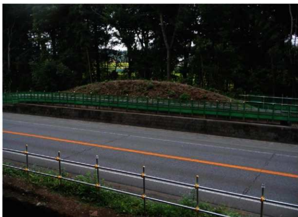
SZ-01 調査前状況（西から）
