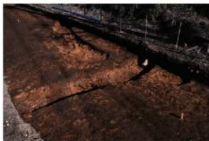
SD-19・20 完掘状況 (南西から)
