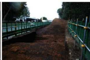
SZ-01 完掘状況 (南から)
