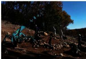
SZ-4 石室天井石撤去作業状況 (西から)
