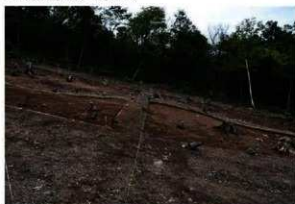
S-6 遺構確認状況 (西から)
