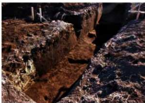
SI-69 完掘状況(北から)
