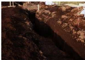
SI-9 完掘状況(南西から)
