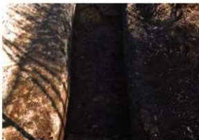
SI-112 完掘状況(西から)
