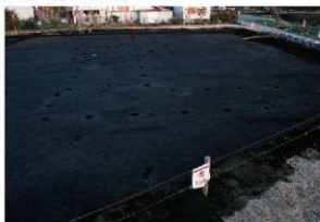
SB-13・14 完掘 (西から)
