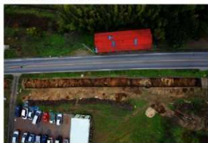
B区全景（西上空から）
