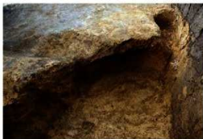
SK-121 挟り込み部（東から）
