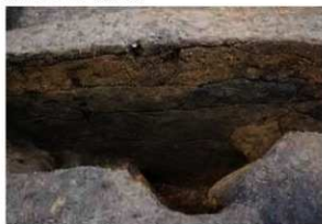
SK-115,SZ-27 重複部土層堆積状況 (南から)
