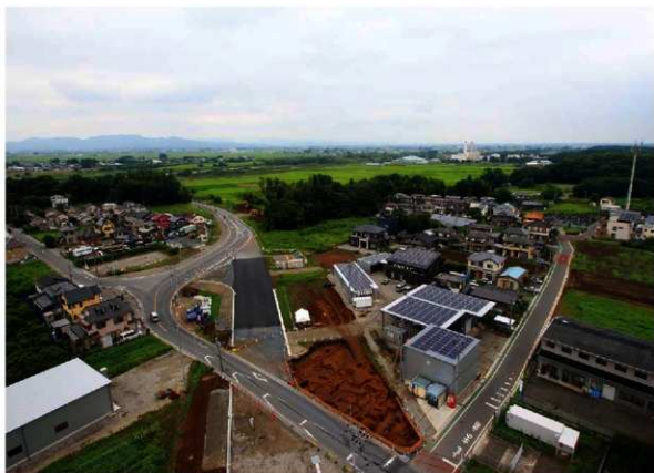
調査区遠景 - 思川をのぞむ (3次調査 A 区) - (西上空から)
