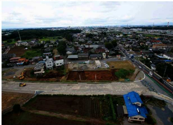
調査区遠景 - 安房神社をのぞむ (3次調査 D 区) - (南上空から)
