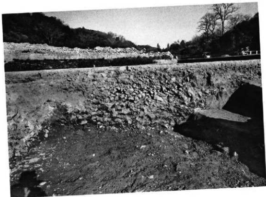
1 C区SX1001 (東から)
