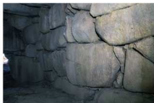
3 緑山8号墳左側壁（東から）
