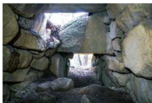
2 稲荷山C 41号墳玄門（北から）
