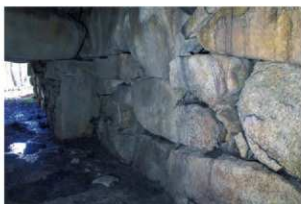
3 稲荷山C 36号墳左側壁 (北から)
