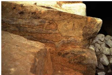
1 墳丘盛土断面 (南から)
