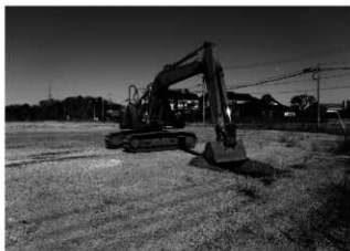
3. 重機による掘削状況(南西→)
