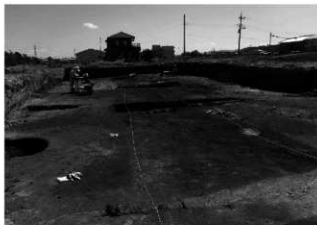
7. E区 東側作業風景(西→)
