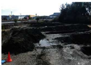
7. トレンチ掘削状況全景 (西→)
