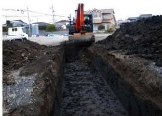
8. 重機による1T掘削状況 (南→)
