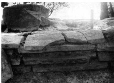
3 同上 階段瓦積細部
