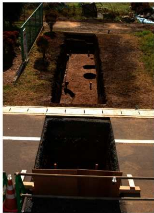
4 調査区南側全景 (1)
