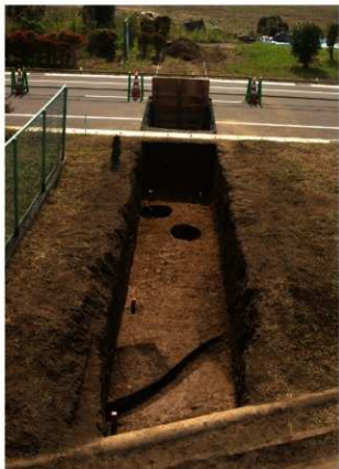
1 調査区北側全景 (1)
