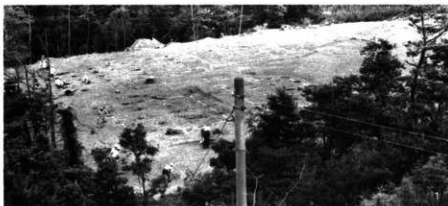
1. 検出された建物群 (東から)
