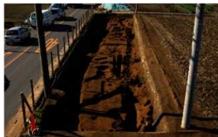
6 ②区調査区全景（東から）
