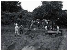
写真3 調査風景(掘削)
