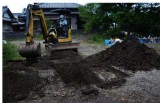
2. 重機によるトレンチ掘削状況 (北東→)
