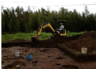
6. 重機による埋戻し状況 (西→)
