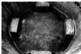
写真3 聴音壕内部の様子 (南東から)
