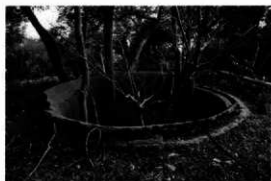
写真7 佐香防空監視哨跡聴音壕(南西から)
