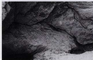
洞穴天井の亀裂 (2)
