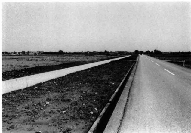
C調査区調査前状況（南東から）
