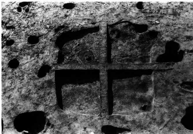
同上 調査状況
