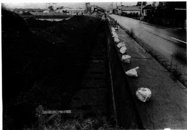
同上 完掘状況(西から)
