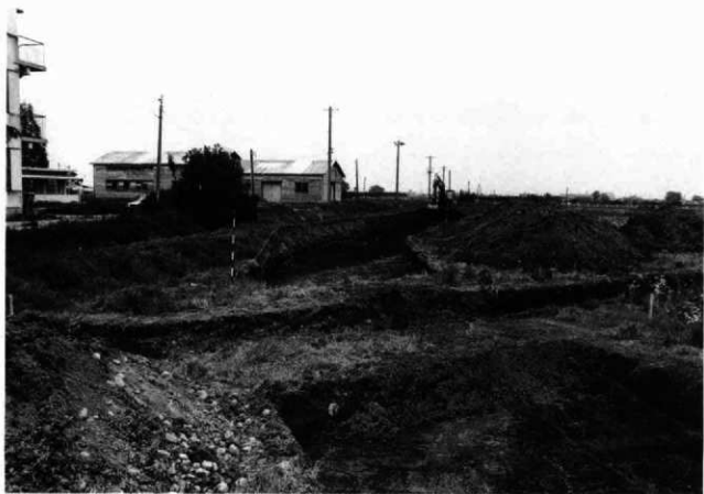
B調査区表土除去作業状況
