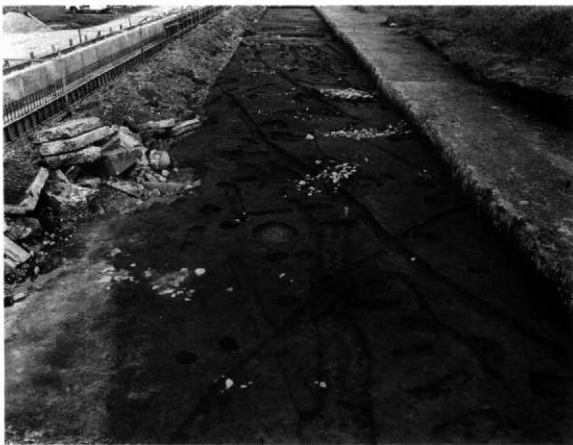
B調査区A5～A8区完備状況（南から）
