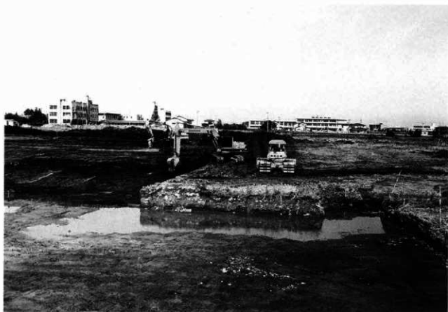
C調査区表土除去作業状況（東から）
