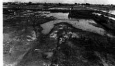
C地区鞍部冠水状況
