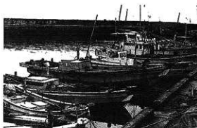
写真3 庄司浦のサツマ型(左から3・4番目)ミヨシが覆っていて船体が低い。
