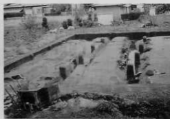
3. 遺構完掘後 (北調査区)
