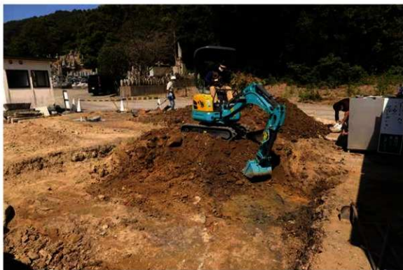
重機掘削作業
