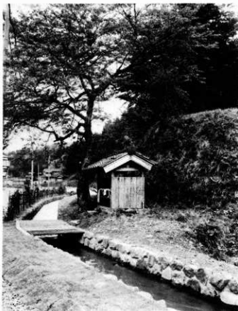
下城戸導水路工 東北から
