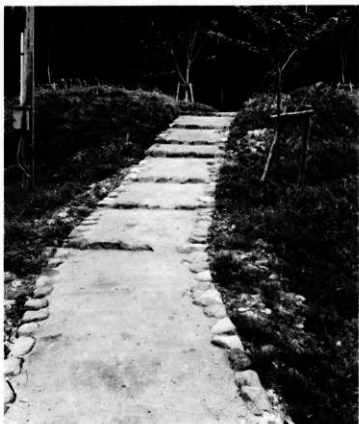
出雲谷園路造成工 西から
