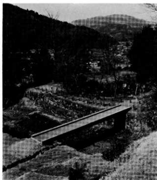
遊歩道橋・園路 東南から
