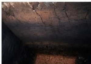
10区基本土層 北から
