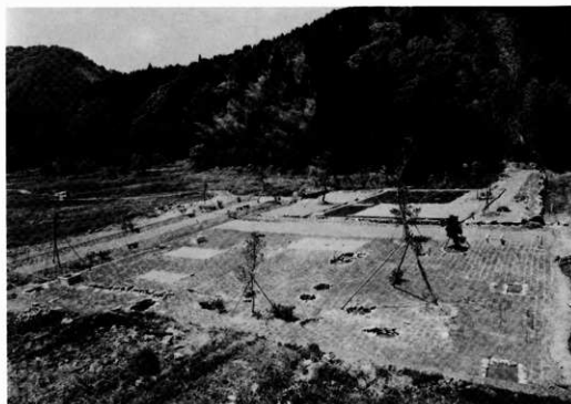
寺院跡整備状況 東北から
