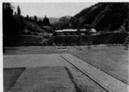
整備後の南面土塁(北から)
