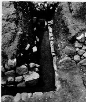
南面土壘暗渠入口(北から)
