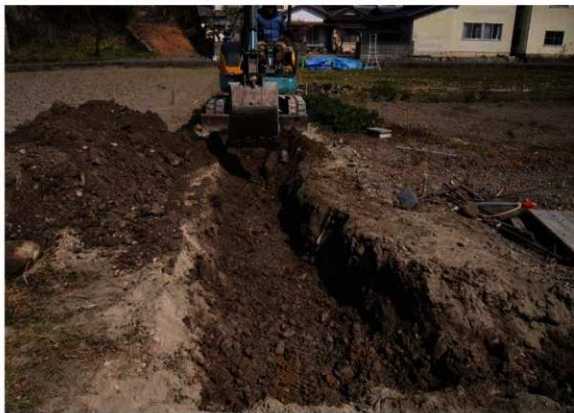
重機掘削中(南から)
