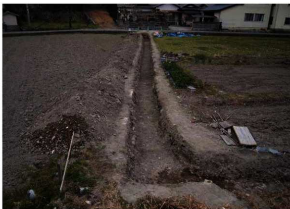
重機掘削後(南から)
