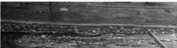
SA 262 南面石垣 (西半部)
