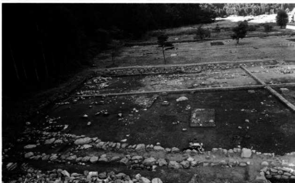
西半部 (南から)
