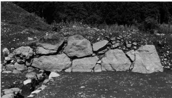
SA 979 東面石垣 (南端部)
