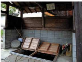
照涌大井戸（平成16年8月25日撮影）
