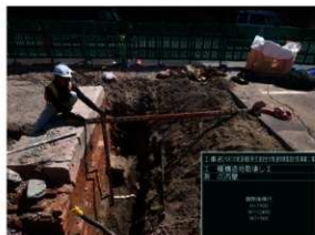
西壁面 掘削完了
