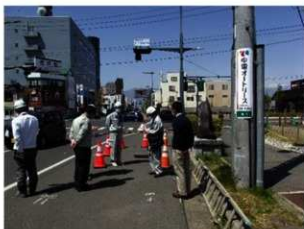
道路拡幅前 車道下部に給水
