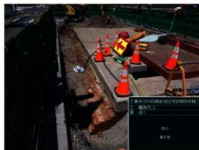
南側壁面上部
