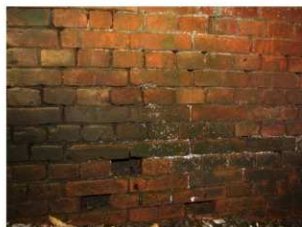
壁面レンガ積み 集水孔
