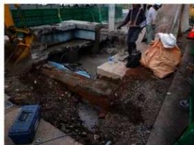
西壁面 取り壊し状況
