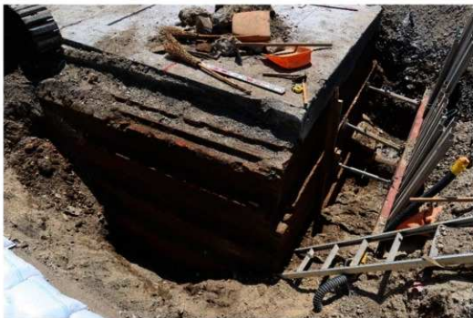
北西隠ぺい部壁面状況
