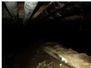
既存配管と堆積土
