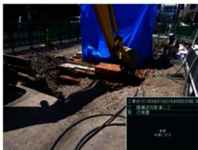
東壁面 取り壊し状況
