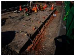
上部床版 全景
