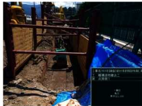
南側壁面 取り壊し完了
