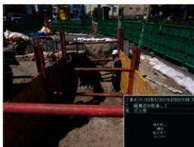
北壁面 取り壊し後
