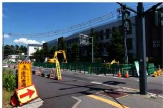
道路工事中 フェンス部分が貯水槽
