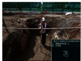
西壁面 取り壊し状況
