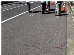
赤いラインが構造物埋設部分
