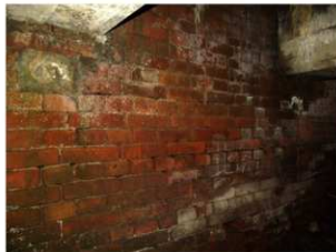
壁面レンガ積み状況
