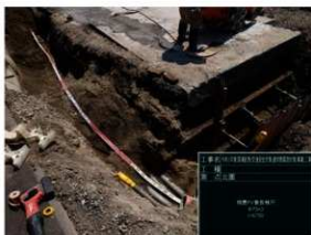
北壁面 掘削状況
