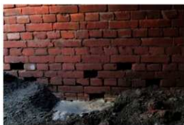
南壁面 レンガ積（集水孔部分）と底部の水
