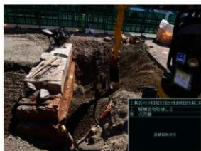
西壁面 側面掘削状況
