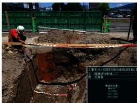
東壁面 取り壊し後
