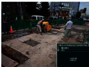
上部床版 切断状況
