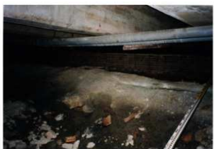
平成9年 内部の状況 2
