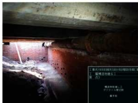
内部構造物 鋼管
