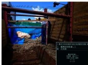
南側壁面 取り壊し完了
