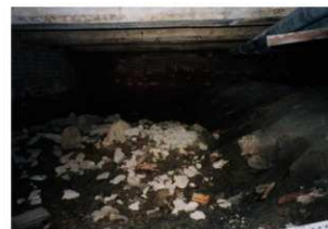
平成9年 内部の状況 1
