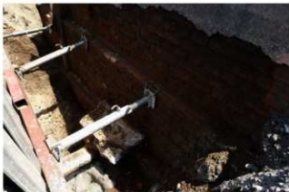
西壁レンガ積み、送水管
