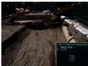
北壁面 埋め戻し
