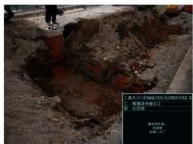
西壁面 取り壊し完了
