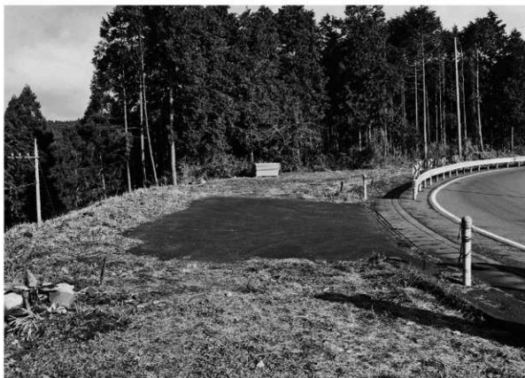
2. 調査前全景（南から）
