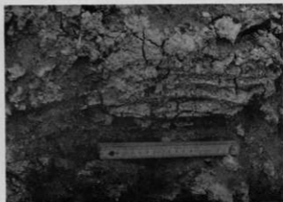
焼成室窯壁修復状況
