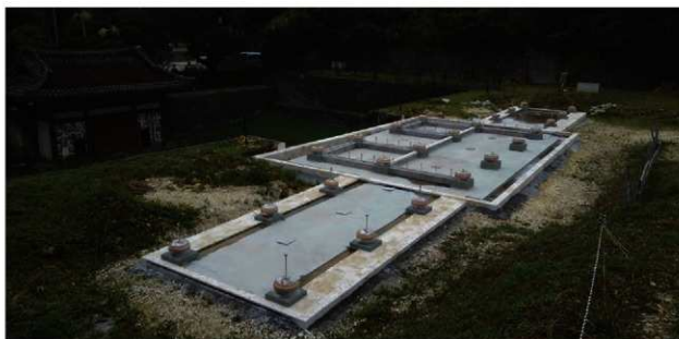
三門基礎コンクリート基礎工事実施後（令和3年度）
