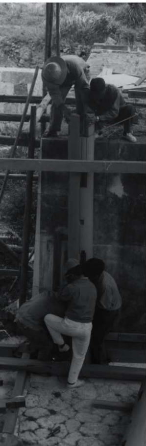
総門の復元工事の様子
