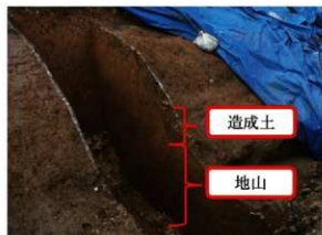
トレンチ1 サブトレンチ5
