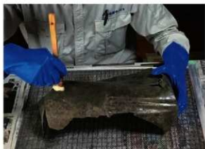
⑨ 接合作業（エポキシ系接着剤）
