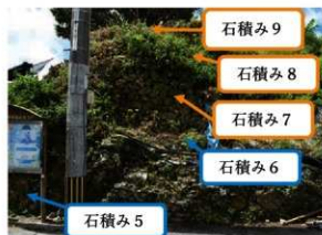
トレンチ1 石積み5～9
