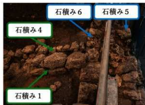
トレンチ2 石積み1・4・5・6
