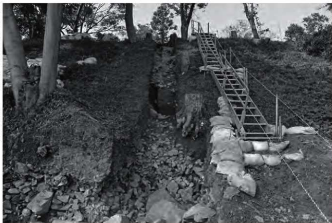
C-3トレンチ全景 下から
