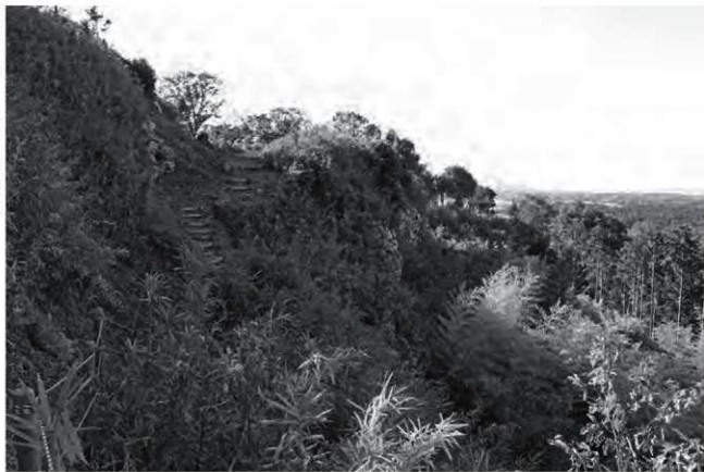
曲輪1-1北面に残る2段の石垣（石垣e-1・2）
