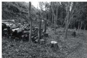
写真17 G-1・2トレンチ調査前
