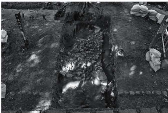
石垣 SW030207 裏込石散乱状況
