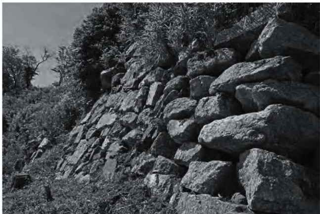
石垣e-2西半部
