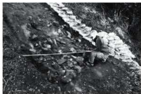
写真2 崩落石垣実測作業 平成24年12月19日撮影
