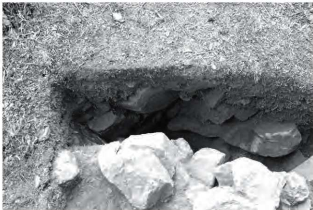
石垣 SW040101 上から
