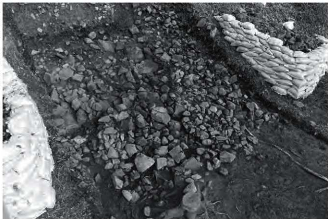
石垣 SW020101 崩落状況上層 西から
