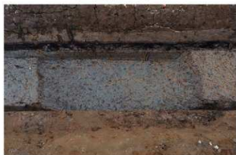
3区 S116 土層断面・完掘(北から)
