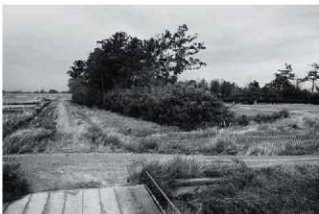
第4図 打越館の土堀(新潟県教育委員会撮影)
