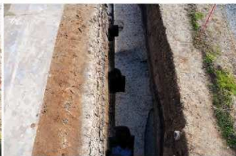
3区 SB71 東側 (P62・32・47) 柱根検出状況 (西から)
