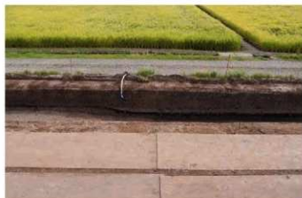
3区 SD2 土層断面東側(北から)
