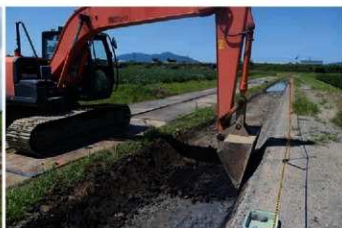
1 区 表土掘削 (東から)
