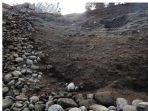
写真7 平櫓石垣背面の盛土、栗石の状況
