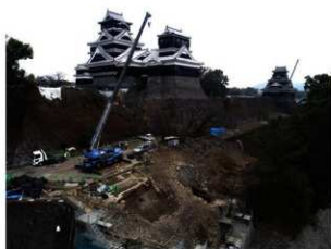
写真6 石垣解体後の平櫓石垣
