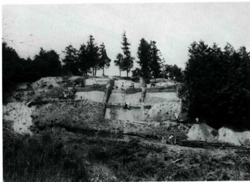
A) 作業風景(南西より)
