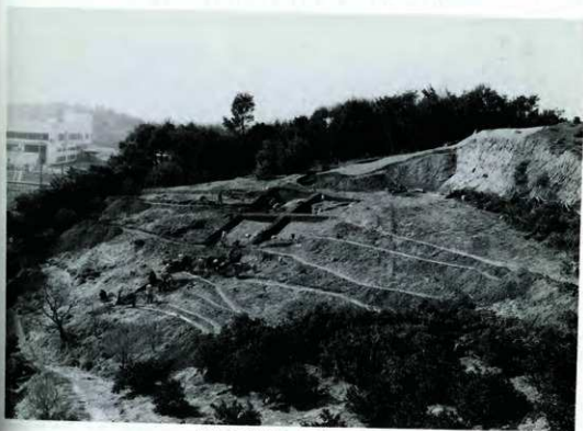
B) 作業風景 (北東より)
