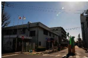
第 90 図 現在の本庁第二・第三庁舎（北西から）
