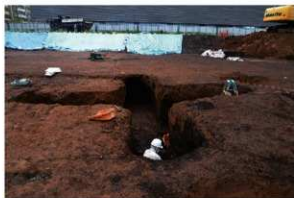
写真 145 SX373 調査作業風景 (南から)
