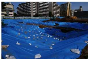
写真 143 調査区養生状況 (南東から)
