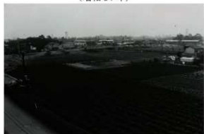
第 103 図 西国分寺駅建設予定地 (昭和 46 年)
