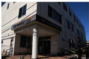
第 89 図 現在の本庁第一庁舎（東から）
