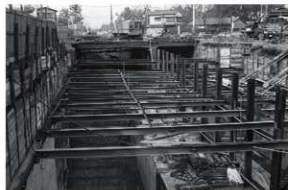
第 102 図 工事中の武蔵野線 (昭和 45 年)
