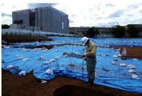
写真 150 測量作業風景 (北西から)
