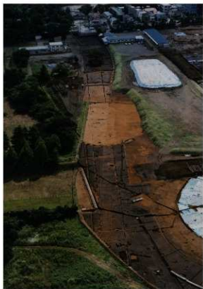
第 114 図 発掘された東山道武蔵路跡(北から)
