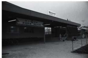
第 104 図 開業した西国分寺駅 (昭和 48 年)
