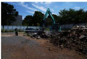
写真 152 コンクリートガラ小割り作業風景 (南から)
