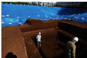
写真 151 試掘トレンチ内作業風景 (北西から)
